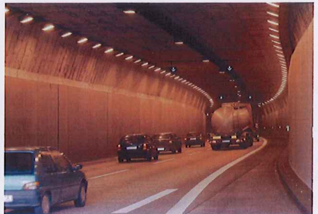
Acabado con revestimiento secundario de paneles de hormigón
