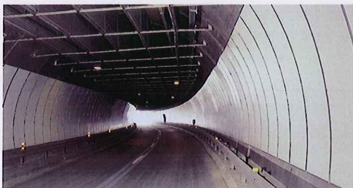
Túnel revestido con paneles de aluminio
